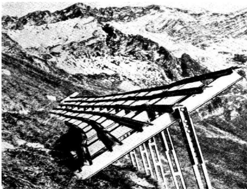
Şək. 8.22. Standart prokat profildən hazırlanmış poladdan olan sipər (Karpat, Slovakiya)
