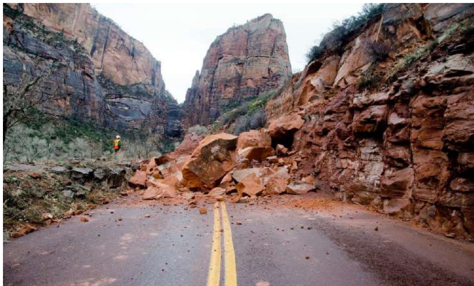
Şək. 2.9. Quba rayonunda (Azərbaycanın şimalı) avtomobil yolunu kəsən uçqunun fotosu (uçqun materialı iri qaya bloklarıdır, hansıların bir hissəsi yol səthinə zərbəsi zamanı yaranmışdır )
