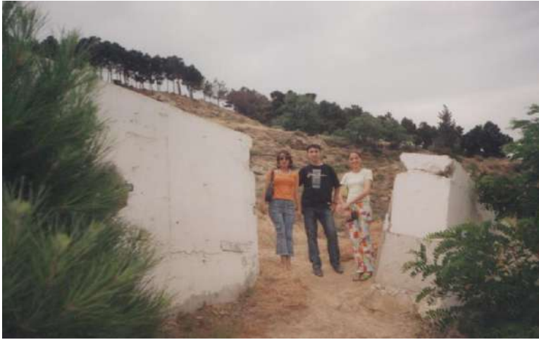
Şək. 1.11. 2010-cu ildə Bakı şəhərində Bayıl sürüşməsi, 15 metrlik svay bünövrələr üzərində istinad divarları (bu divar 2000-ci ildə sürüşmə dilinin üzə çıxma zonasında faciəli sürüşmə nəticəsində qaldırılmış və yelping şəklində çevrilmişdir)
