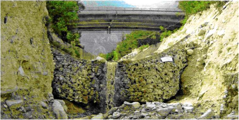
Şək. 6.24. GEOBRUGG VX/UX elastik seldən mühafizə çəpərinin fotosu a- sel keçənə qədər; b- sel keçdikdən sonra
