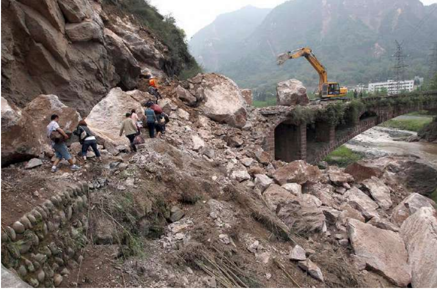
Şek. 2.5. Çində çaydan küçən körpü dayaqlarının birinin zonasında iri uçqunun fotosu: yekə qaya parçalardan biri körpünü tamamilə örtüb
