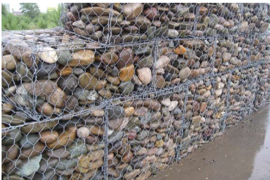
Şək. 5.30 – “Officine Maccaferri” qutu qabionlarla sahilin bərkidilməsi
