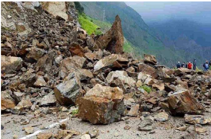
Şək. 2.6. Kənd avtomobil yolunu kəsən (Gürcüstan) uçqunun fotosu: qarışıq uçqun materialları (kiçik və orta qırıntılar və dağ süxurlarının iri blokları)
