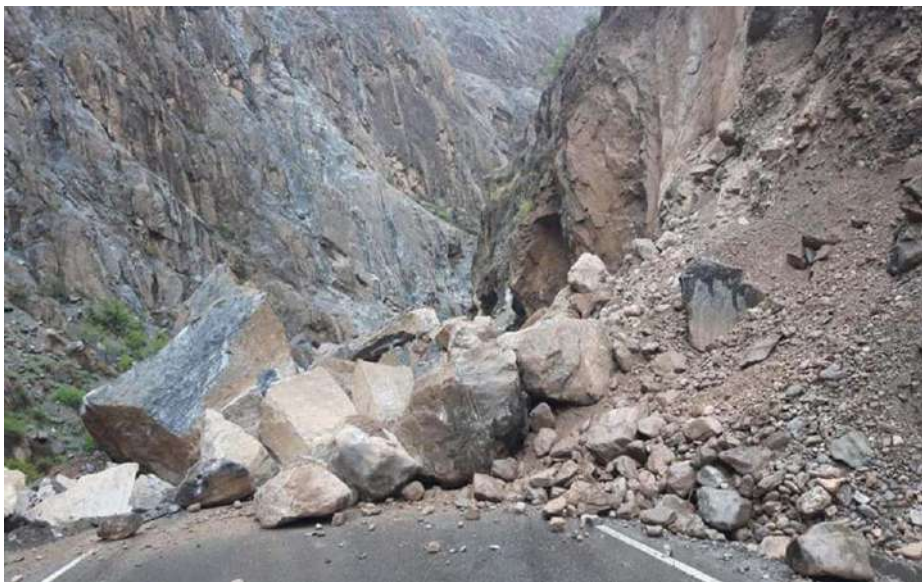
Şək. 2.8. Tacikstanın dağ rayonunda avtomobil yolunu kəsən uçqunun fotosu (uçqun materialı iri qırıntılı bayıra düşmələrdir)
