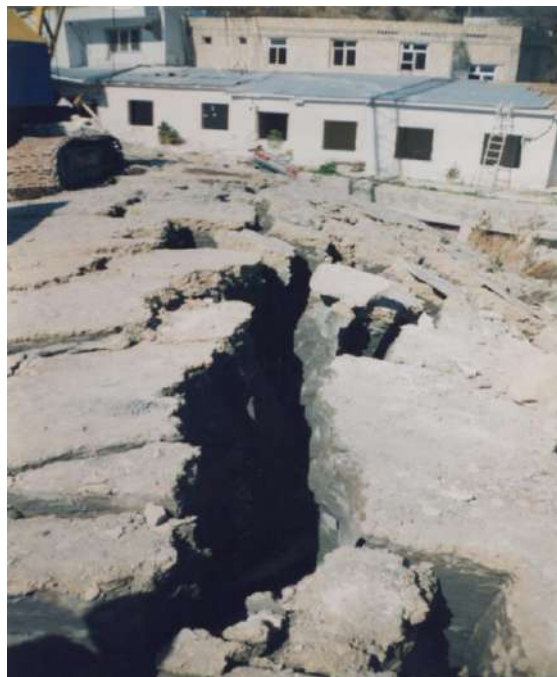
Şək. 1.8. 2000-ci ildə Bakı şəhərində Bayıl sürüşməsi, sürüşmə dilinin üzə çıxdığı ərazidə dağılma
