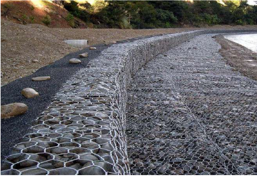
Şək. 5.31 – “Officine Maccaferri” firmasının qutu və döşək qabionları vasitəsilə çay sahilinin bərkidilməsi
