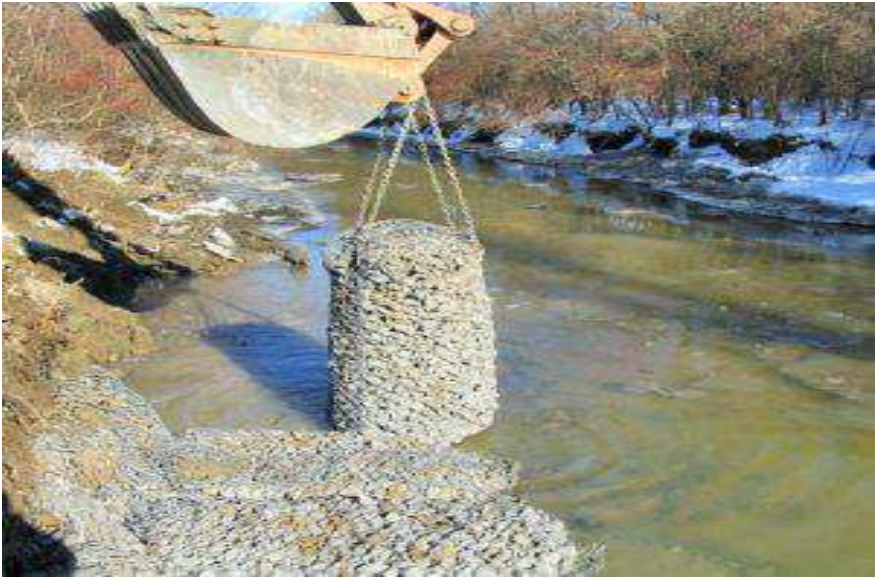
Şək. 5.32 – “Officine Maccaferri” firmasının dairəvi həsir qabioununun sahilbərkidici konstruksiyaya döşənməsi
