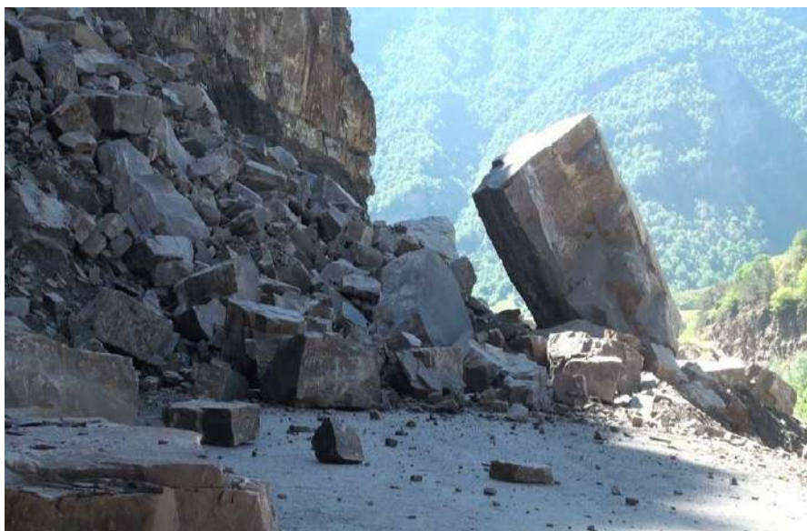
Şək. 2.7. Dağıstanda (Rusiya) dağ yolunu kəsən iri uçqunun fotosu (uçqunun materialı qaya süxurların iri bloklarıdır)
