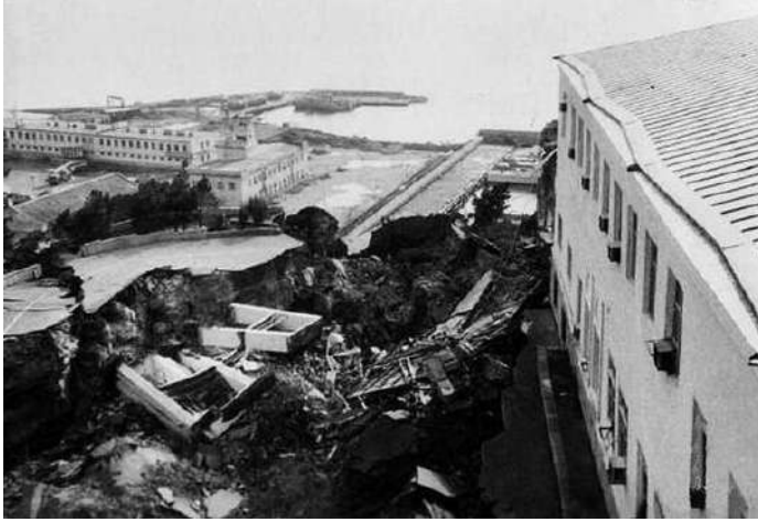
Şək. 1.12. Bakı şəhərində Bayıl “şişində” yerləşən hərbi hissənin ərazisi, 15.01.1990-cı ildə baş vermiş sürüşmənin yaratdığı dağıntılar
