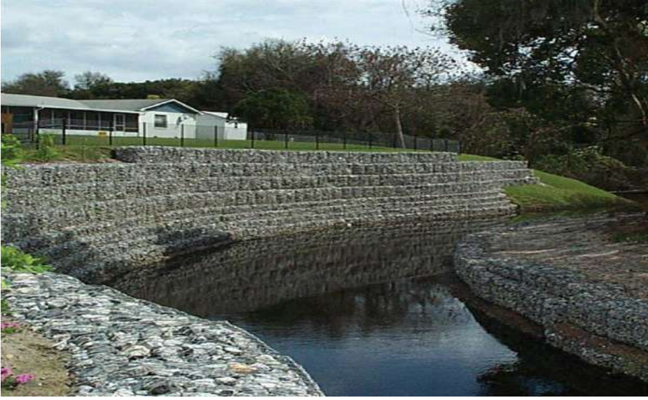
Şək. 5.33 – “Officine Maccaferri” firmasının qutu qabionları ilə kanal sahilinin bərkidilməsi.
