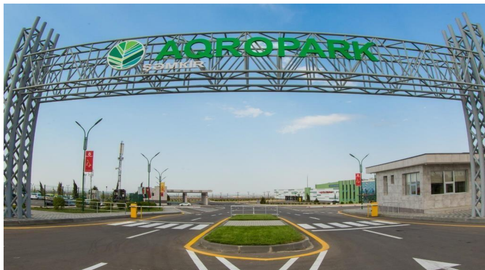
Şəkil 1. Şəmkir Aqropark Kompleksi
