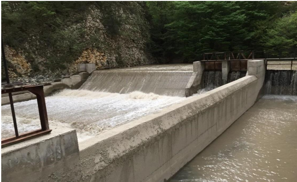
Şəkil 4. Suqəbuledici qurğunun ümumi görünüşü
