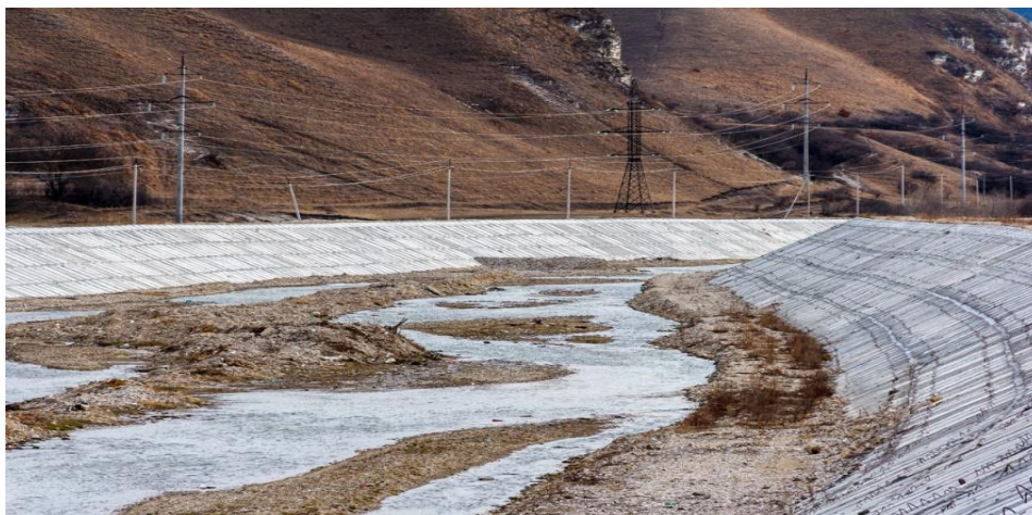
Şəkil 6. Monolit dəmir beton sahil mühafizə qurğusu
