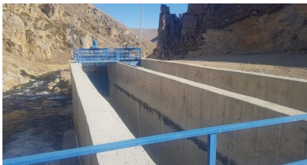
Şəkil 1. Yeni tikilmiş durulducunun ümumi görünüşü
