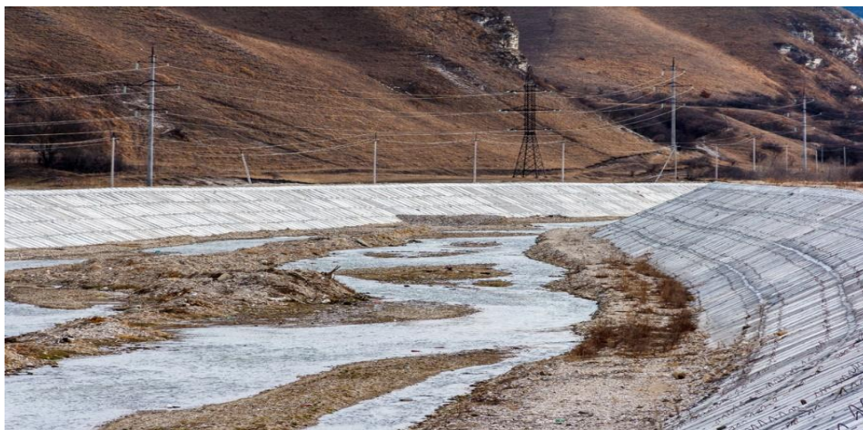
Şəkil 6. Monolit dəmir beton sahil mühafizə qurğusu
