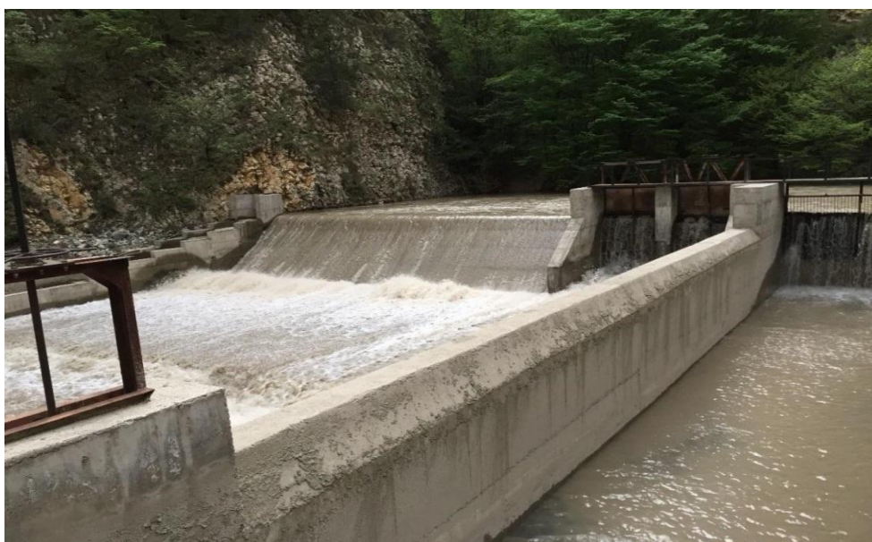
Şəkil 4. Suqəbuledici qurğunun ümumi görünüşü
