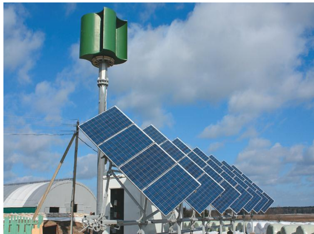
Şəkil 1.3.2. BEM əsasında hibrid sistem
