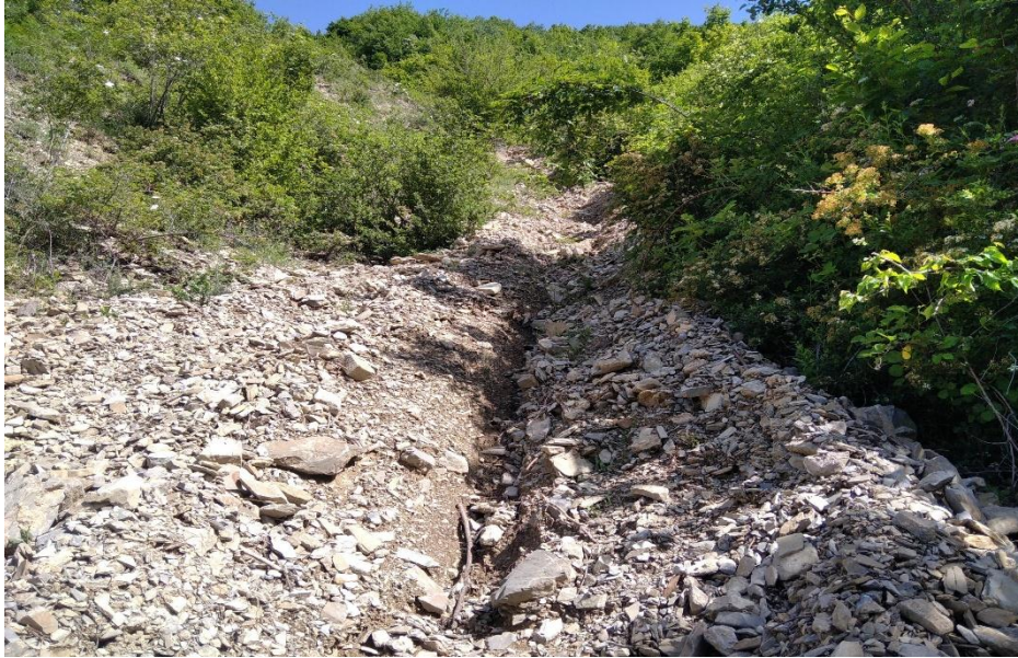
Şəkil 3. Şəkildə Şəki rayonu Şin kəndi ərazisində yerləşən Qafqaz dağlarında xətti eroziya prosesi müşahidə olunur. Bu prosesi aşınmanın bir növüdür . Bu aşınma həm təbii proseslər nəticəsində ( intensiv yağışlar nəticəsində axar suların təsirindən ), həm də insan fəaliyyəti nəticəsində ( meşələrin qırılması və qırılmış meşə materiallarının həmin qeyd etdiyimiz yerdən aşağı dartması nəticəsində) baş verir. May 2023, ( N 41°21'26", E 47°7'3" ) h=1130 m
