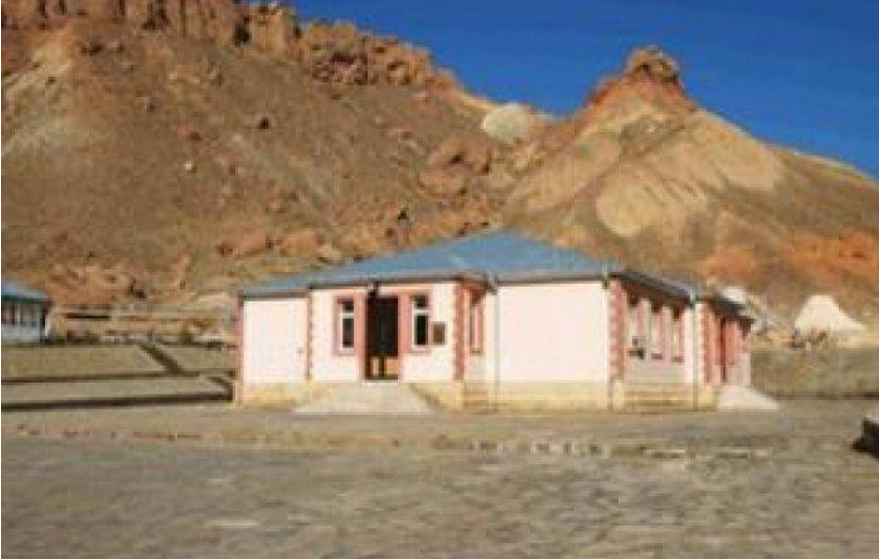
Şəkil 3.6. Darıdağ Arsenli Su Müalicəxanası
