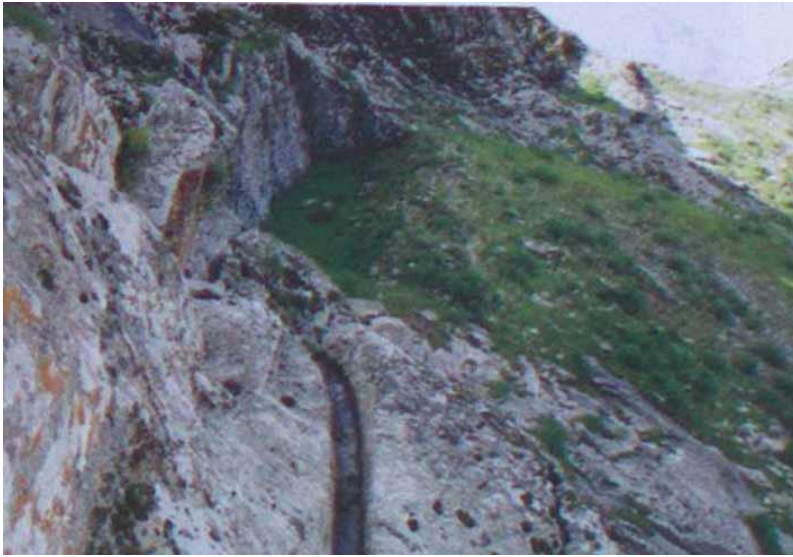
Şəkil 2.6. Əlincə qayalarında süni sutoplayıcı kanal
